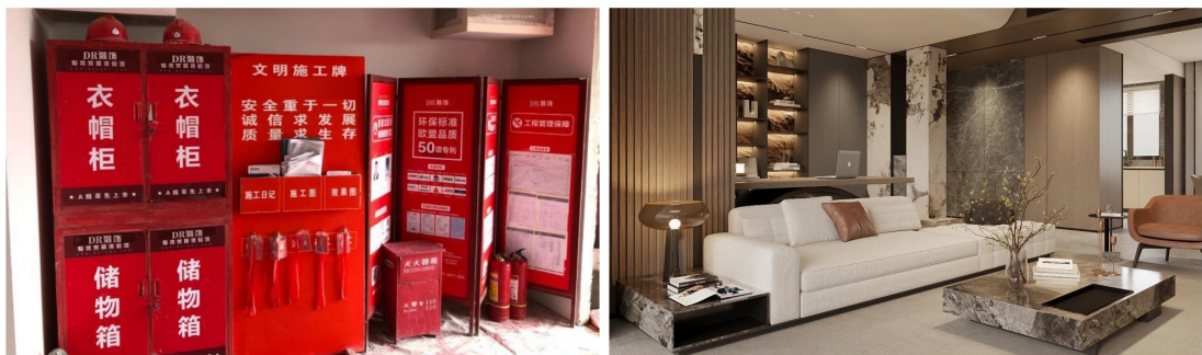
图3.10 DR公司施工现场和样板间
